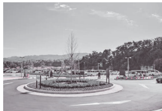
ラウンドアバウトを導入した駐車場。渋滞の緩和が期待されます。
