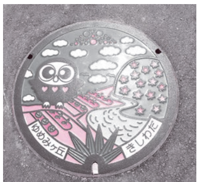
ゆめみヶ丘のシンボル「フクロウ」が描かれた公園内のマンホール。災害時は仮設トイレになります。
