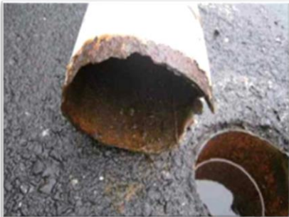
根腐れによる破断
