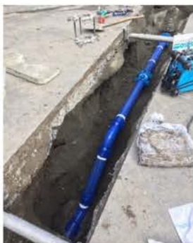
写真：老朽化管路の更新
