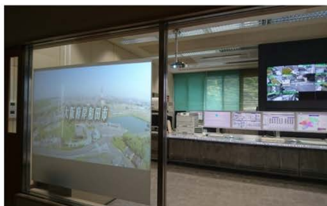
写真：流木浄水場管理棟内
