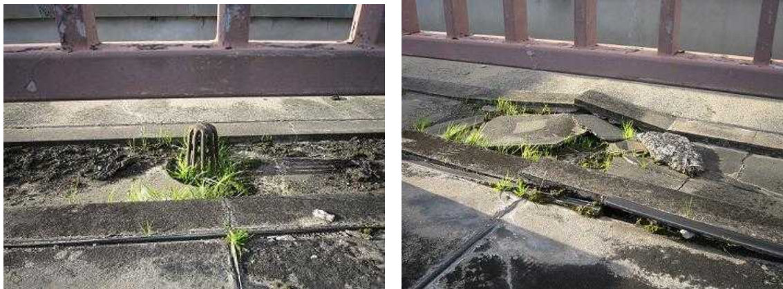
図1 本市庁舎屋上の様子
