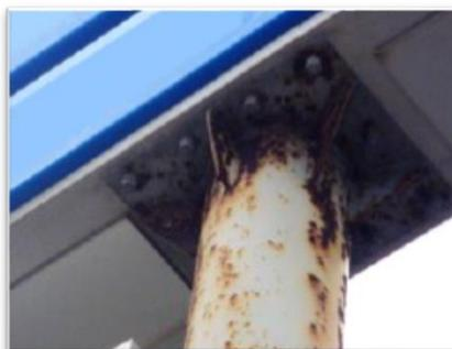
鉄骨接合部の腐食
