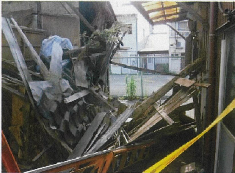
当該家屋の北東側から北面撮影
