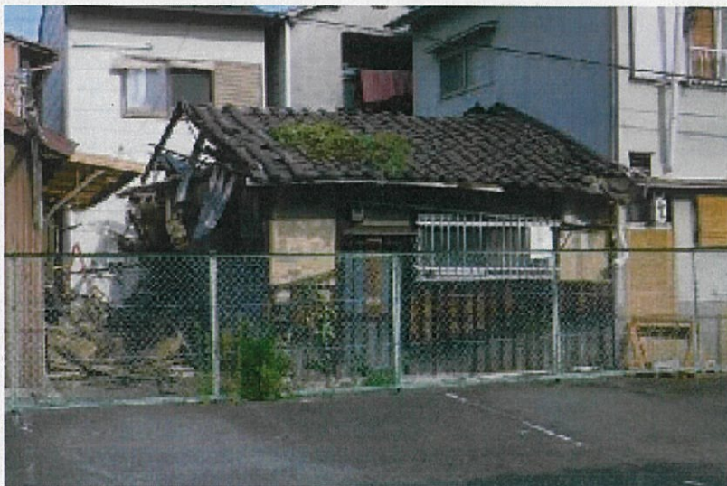
当該家屋の西側駐車場内から
