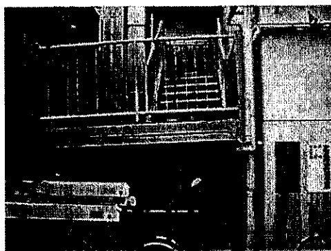
屋外階段が傾斜している
