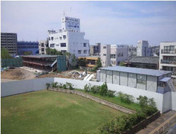
解体工事中（平成28年5月19日）
