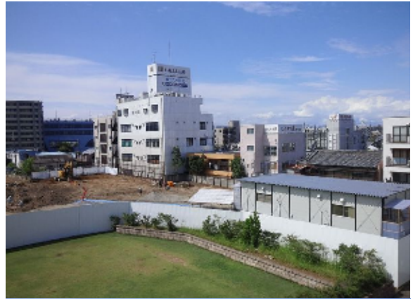
解体工事中（平成28年6月9日）
