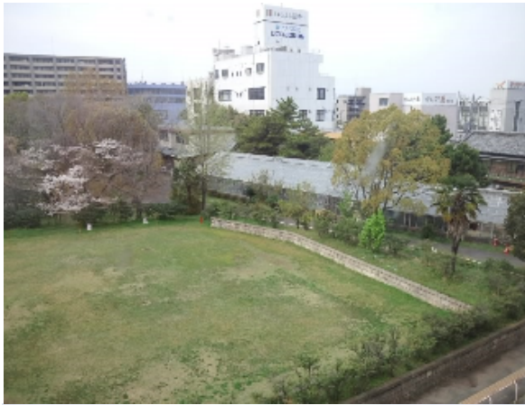
解体工事着手前（平成28年4月8日）
