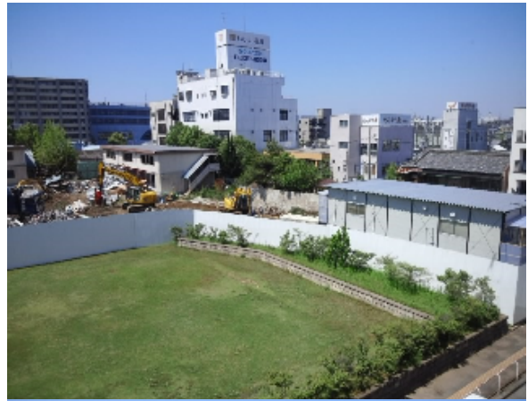
解体工事中（平成28年5月12日）
