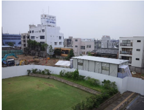
解体工事中（平成28年5月28日）
