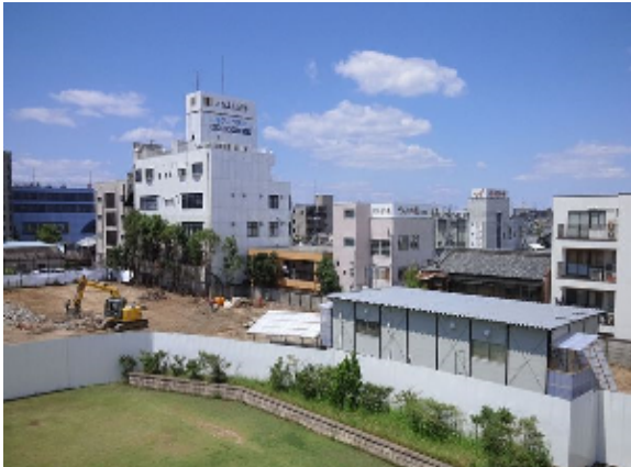
解体工事中（平成28年6月2日）
