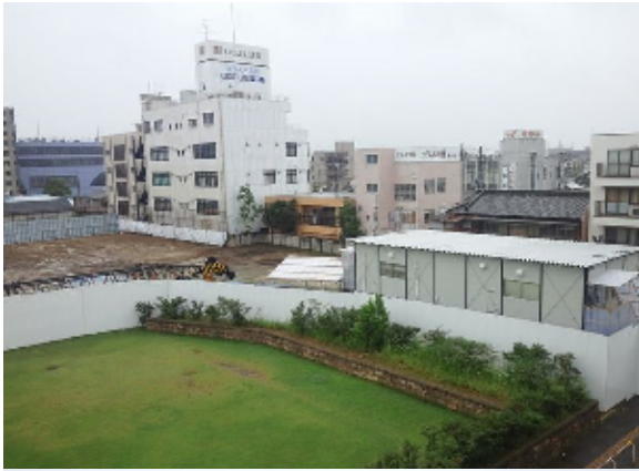
解体工事現場（平成28年6月16日） 作業は完了し杭打ち用の重機が搬入されています
