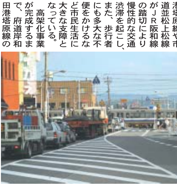
渋滞する踏切（東岸和田駅付近）
