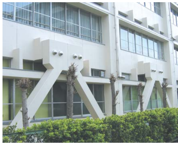
耐震補強の施された校舎(城北小学校)
