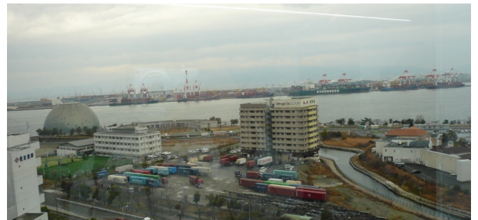
EXPO2025の工事の様子(海を挟んで奥)
