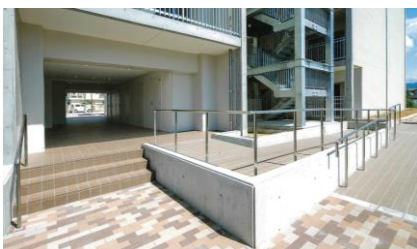
手すり・スロープ設置(市営山下住宅)
