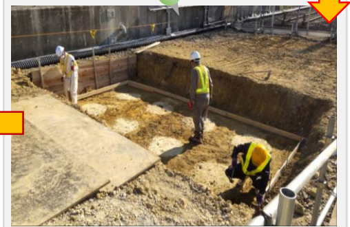
地盤改良工事
