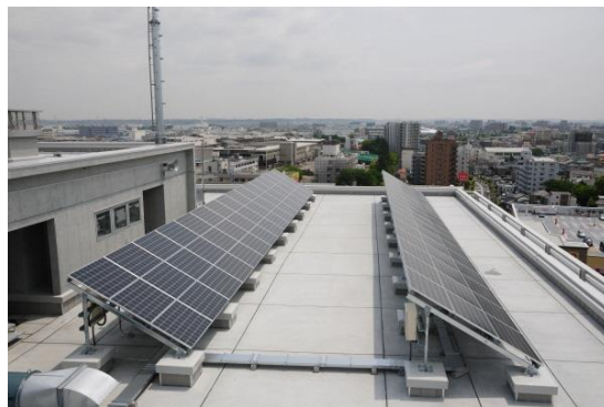
屋上に太陽光パネルの設置（平塚市）
