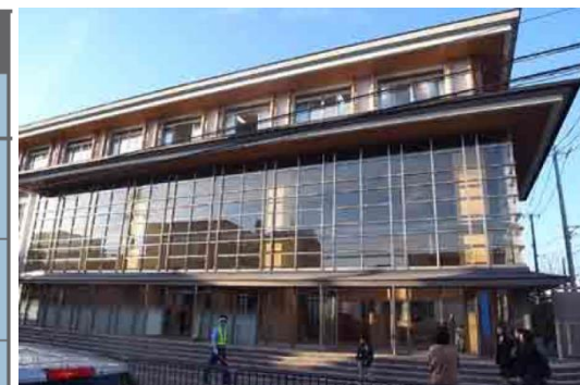
西学舎(ファーストステージ):一橋小敷地に建設された新校舎
