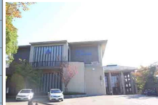
東学舎(セカンドステージ):月輪中を増築・改修 ※両校舎間の距離は約750m
