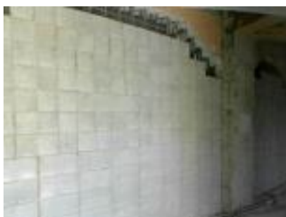
耐震ブロック工法
