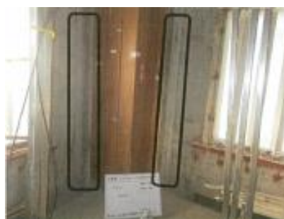
耐震スリット補強
