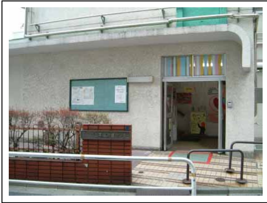
写真5 ティーンズプラザ入口
