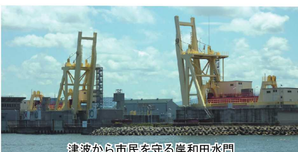
津波から市民を守る岸和田水門
